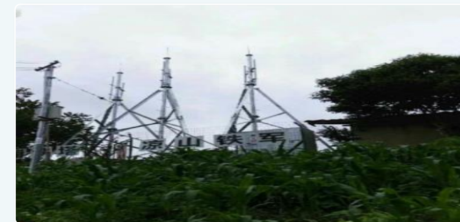
▲ 凉山悬崖村基站建设
